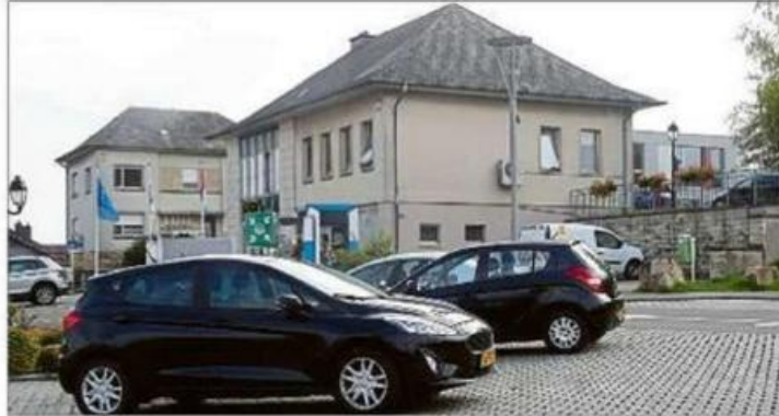
Das neue Gemeindehaus ist auf dem Parkplatz neben dem alten Rathaus vorgesehen. Nach dem Abschluss der Arbeiten wird der Altbau abgerissen. (FOTO: RAYMOND SCHMIT)
